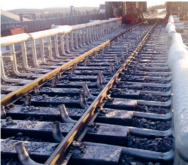
Genom rören i banvallen blåses den varma luften för att tina malmvagnarna.
