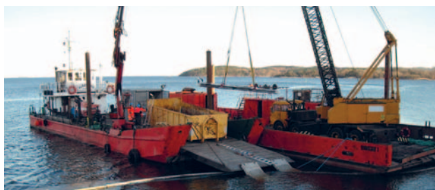
Från den här arbetsplattformen utför FriGeo sina frysupdrag.
